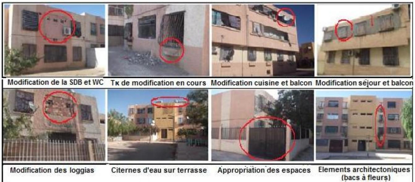
Figure 12 : Les déformations et dégradations observées.
