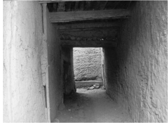
Figure 1 : Le passage couvert est une des configurations urbaines favorisant l'atténuation de l'intense rayonnement solaire à l'extérieur des bâtiments.
