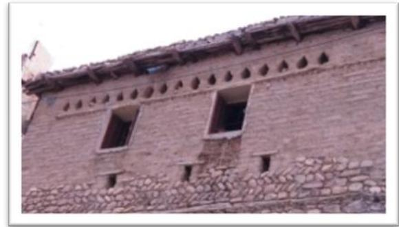
Figure 03 : Forme des fenêtres ( triangulaires et rectangulaires ) (Source : Auteur, 2016)
