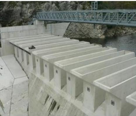
Figure 01: Déversoir en labyrinthe du barrage de Song Mong (Vietnam) et le déversoir en touches de piano du barrage Malarce(France)
