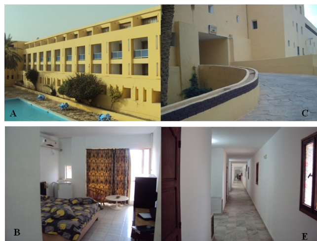
Fig. 2. Des vues intérieures /Extérieures sur l'hôtel des Zibans.
