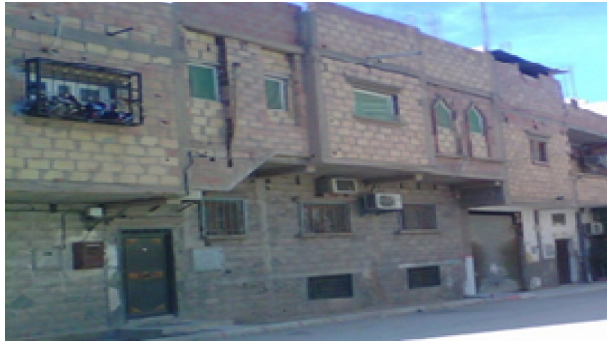
Fig. 2. Habitat « auto-construit » dans la ville de Biskra.
